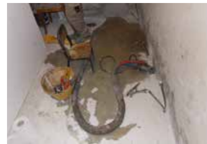
La résine Uretek est injectée par des forages dans les murs.
