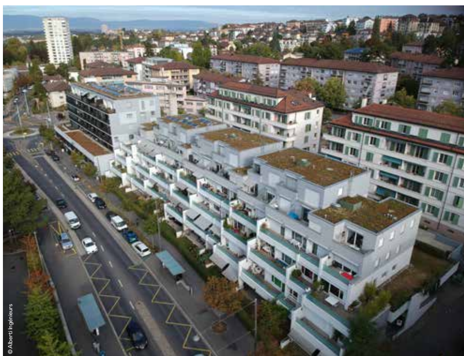
La surélévation a repris les codes en dénivelé du bâtiment existant.
