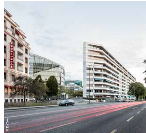
A Genève, trois niveaux ont été ajoutés sur cette barre des années 60. Un projet des architectes Lacroix Chessex.
