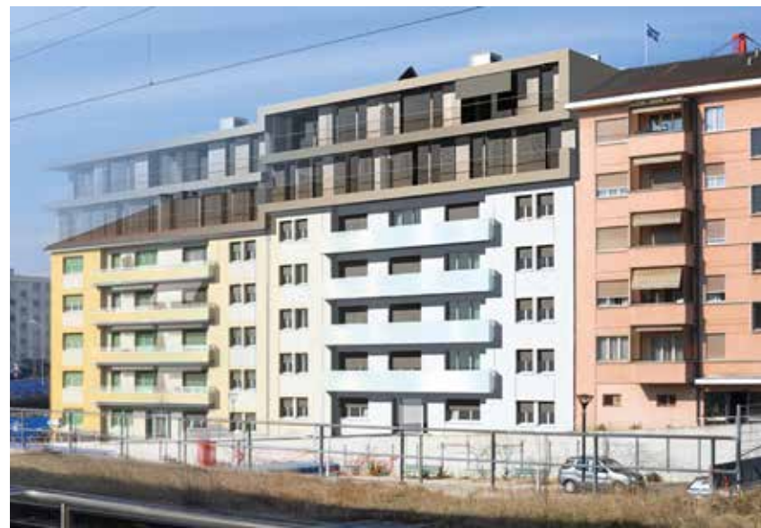
Les immeubles, avant et après leur surélévation avec, à gauche, l'ancienne toiture.
