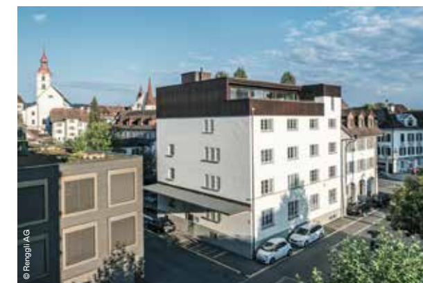
Surélévation avec création d'une terrasse.
